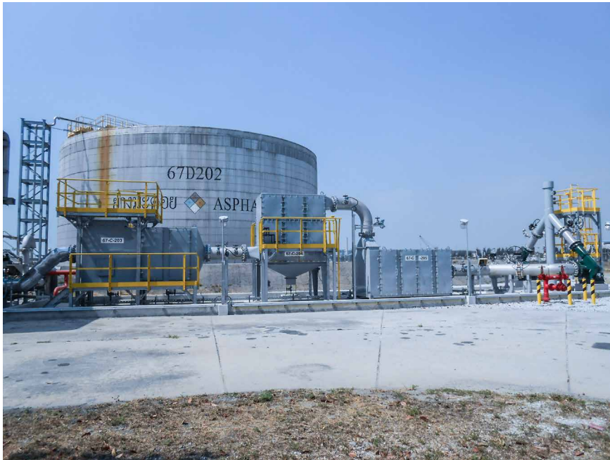
ระบบลดกลิ่นจากถังเก็บยางมะตอยที่ทำเทียบเรือ
