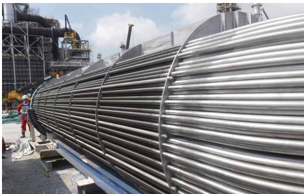
การติดตั้งชุดท่อ (tube bundle) ภายในเครื่องแลกเปลี่ยนความร้อน
