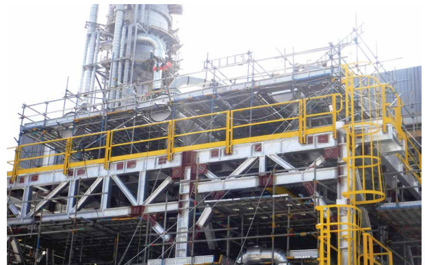
การติดตั้งเครื่องแลกเปลี่ยนความร้อนใหม่เพื่อเพิ่มประสิทธิภาพการนำพลังงานกลับมาใช้ใหม่
