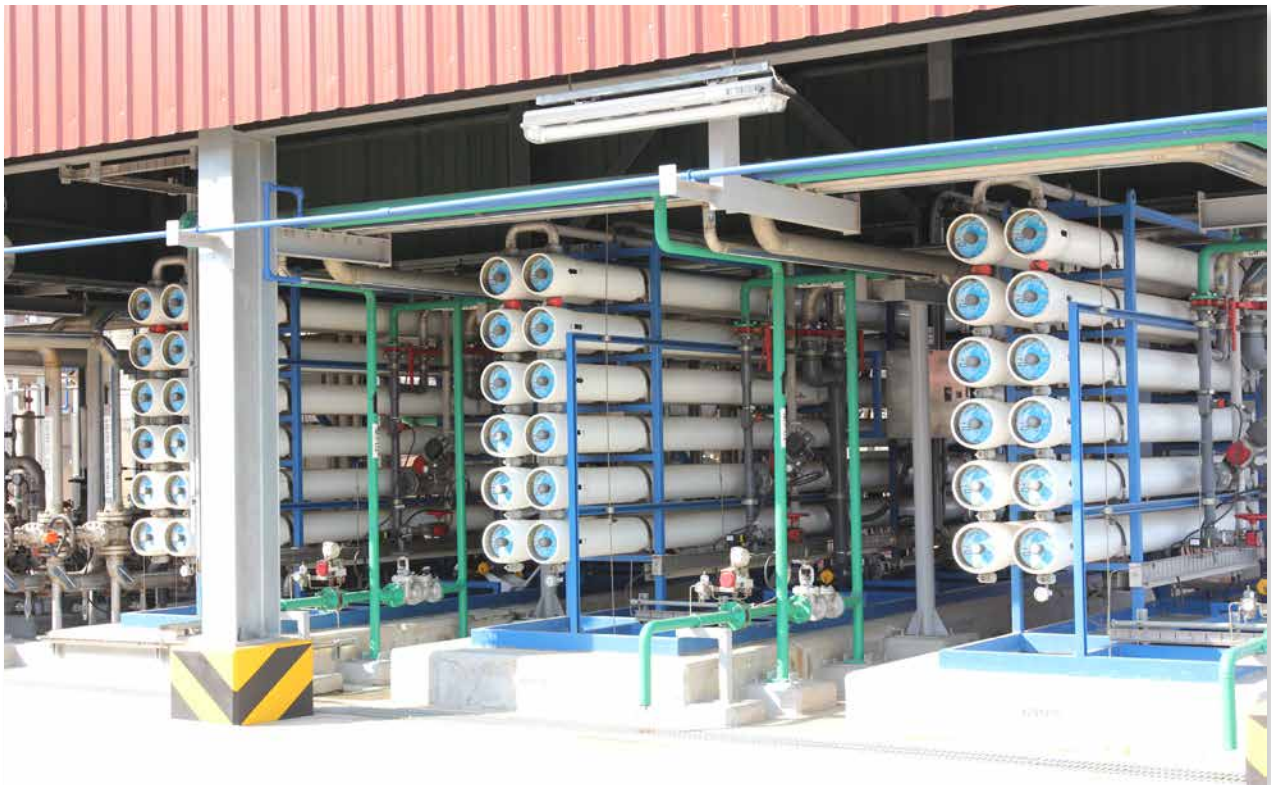
ใช้ไส้กรองรีเวอร์สออสโมซิสเพื่อกำจัดสารปนเปื้อนในน้ำ โดยเครื่องกรองน้ำระบบรีเวอร์สออสโมซิสขั้นที่ 2 ซึ่งประกอบด้วย 3 หน่วย (สำหรับใช้งาน 2 หน่วยและสำรอง 1 หน่วย)
