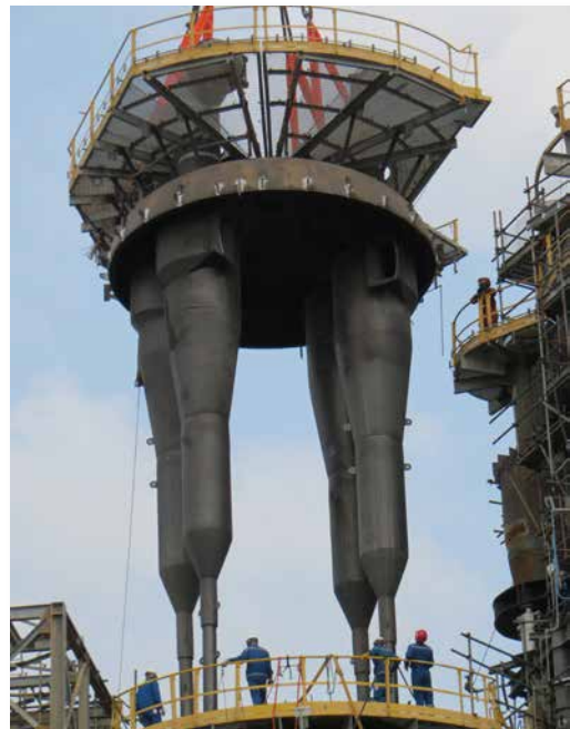
การติดตั้งไซโคลนใน Reactor และ Regenerator ที่หน่วยแตกตัวน้ำมันหนัก (RFCCU) ในปี 2557 ระหว่างช่วงซ่อมบำรุงรักษาเครื่องจักรและตรวจสอบ ทั้งนี้จากการดำเนินโครงการสามารถลดการปล่อยอนุภาคได้ร้อยละ 63
